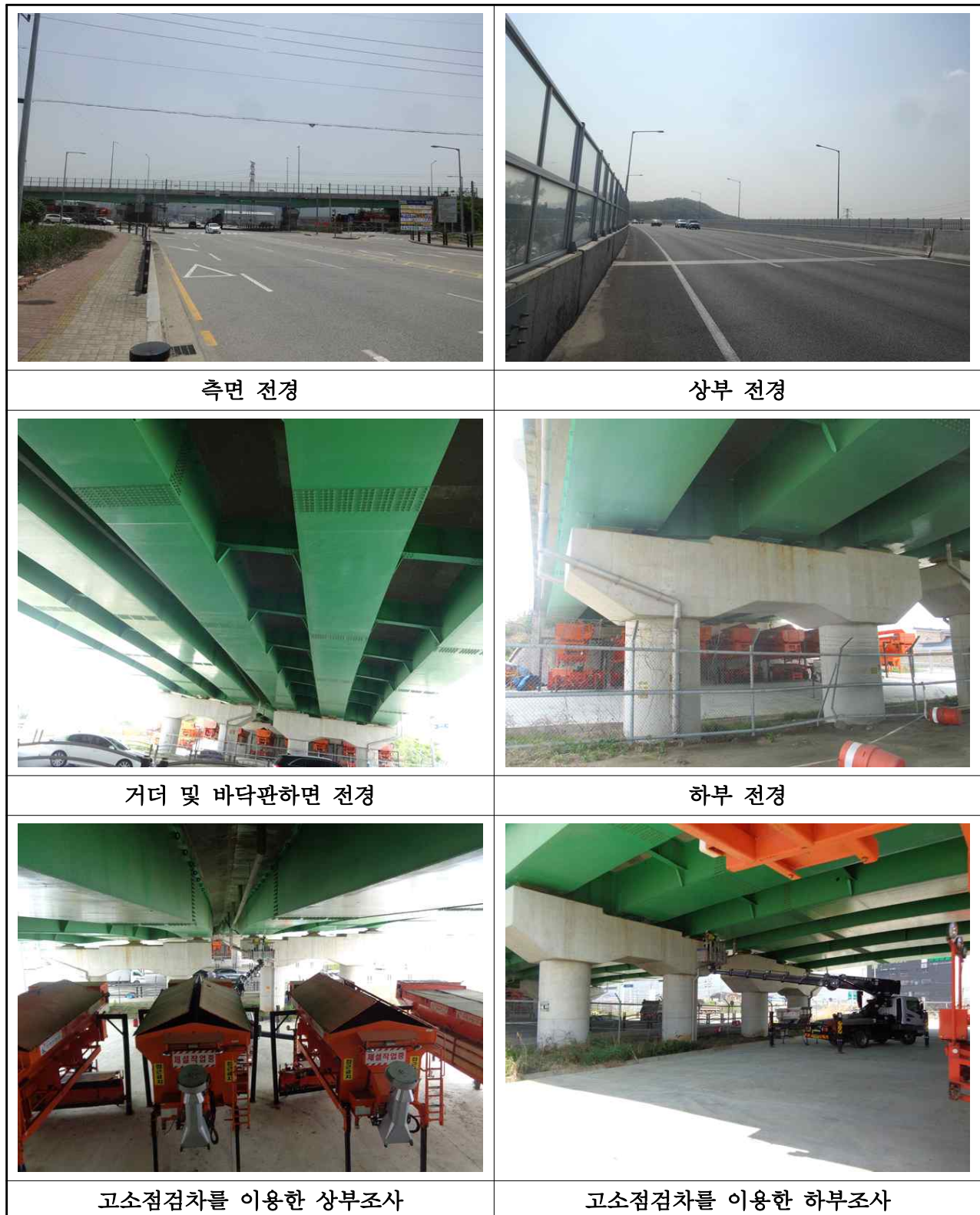
【사진 3.1】근접조사를 위한 장비 사용 전경
