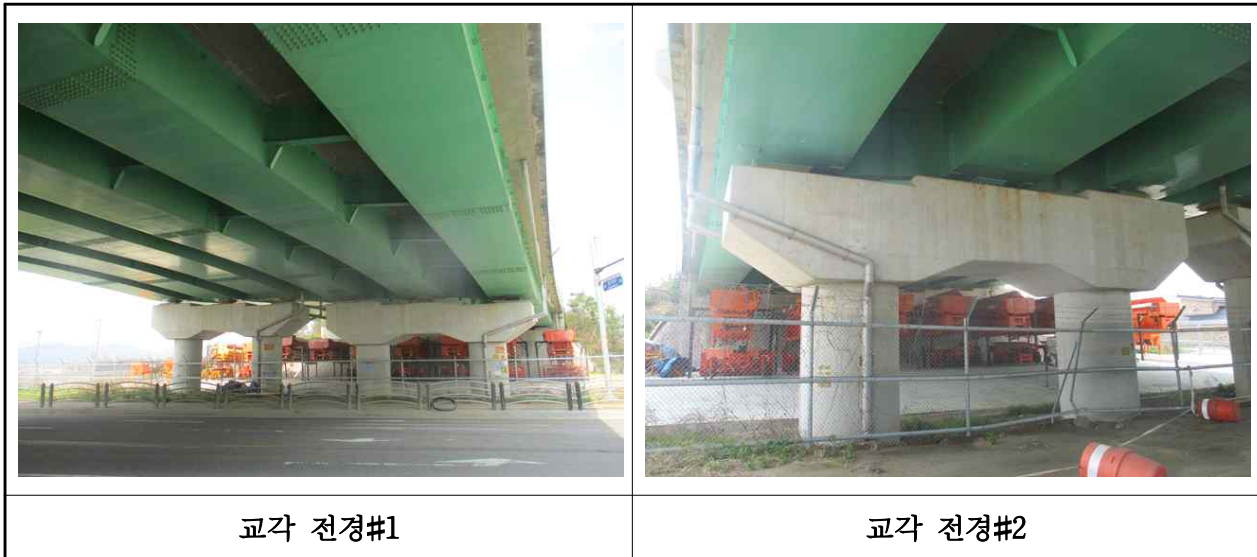
【사진 3.11】 교각 전경
