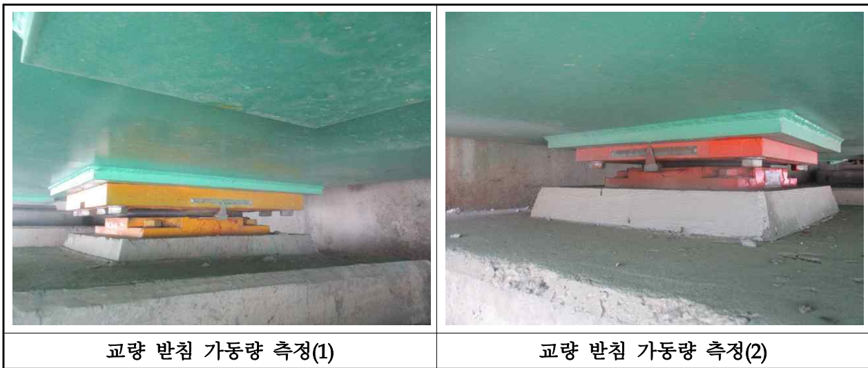
【사진 3.16】 교량받침 이동량 측정
