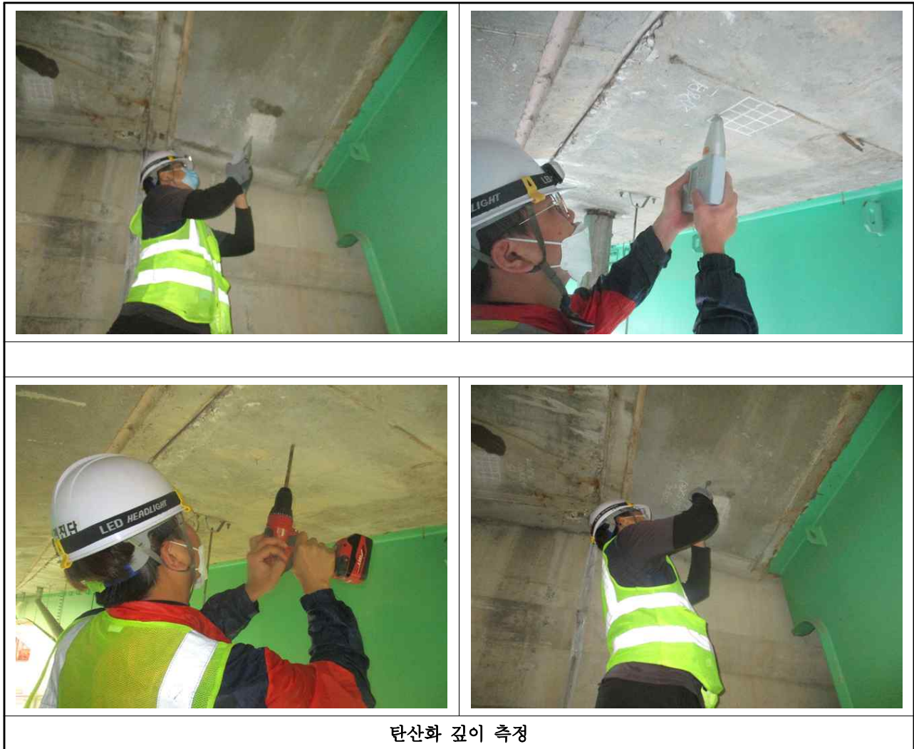
【사진 3.25】 콘크리트 내구성조사 현황
