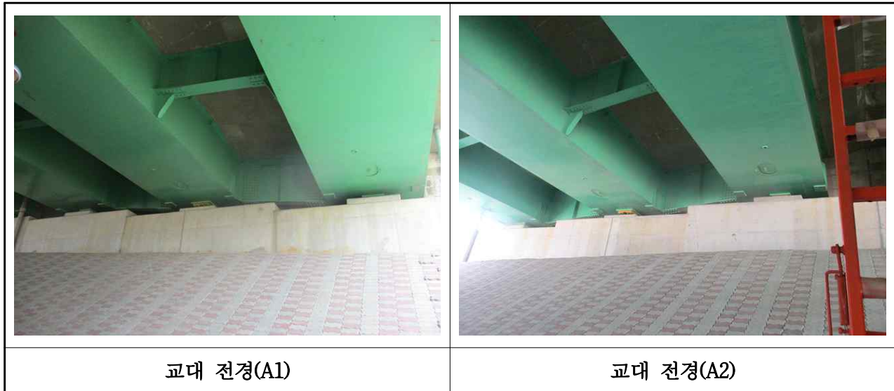
【사진 3.9】 교대 전경
